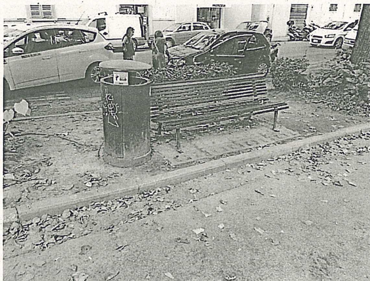
Foto 49: Piazza Pier Vettori: gradini per accedere alle panchine
